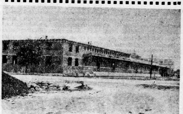
Rövidesen befejezik a műtrágya és növényvédőszer raktárának építését. Az építkezés még egymillió 40 ezer forint beruházást igényel.
