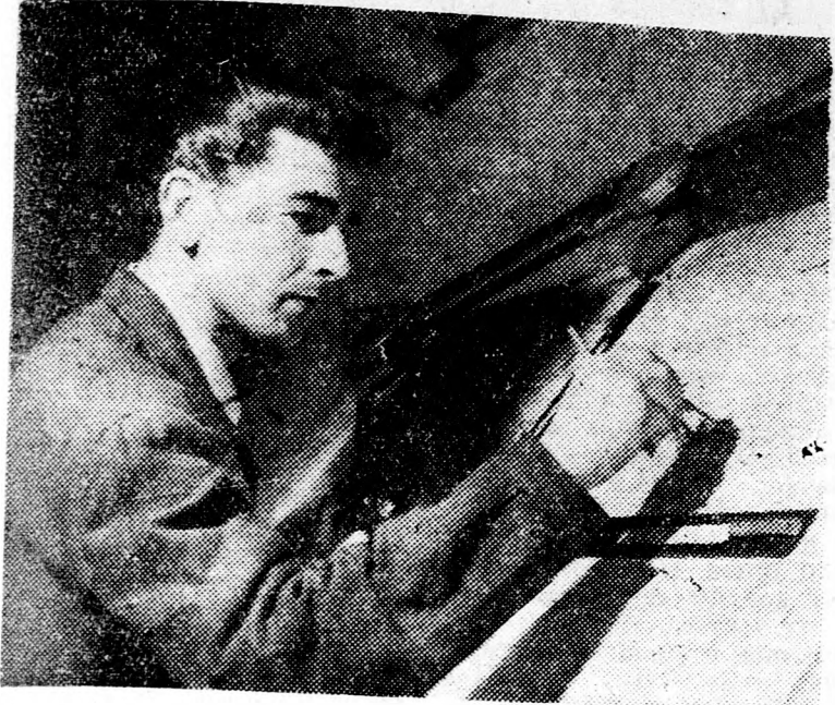
Csekey Lajos szerszámkészítő bakelit présszerszám tervezésén dolgozik.
