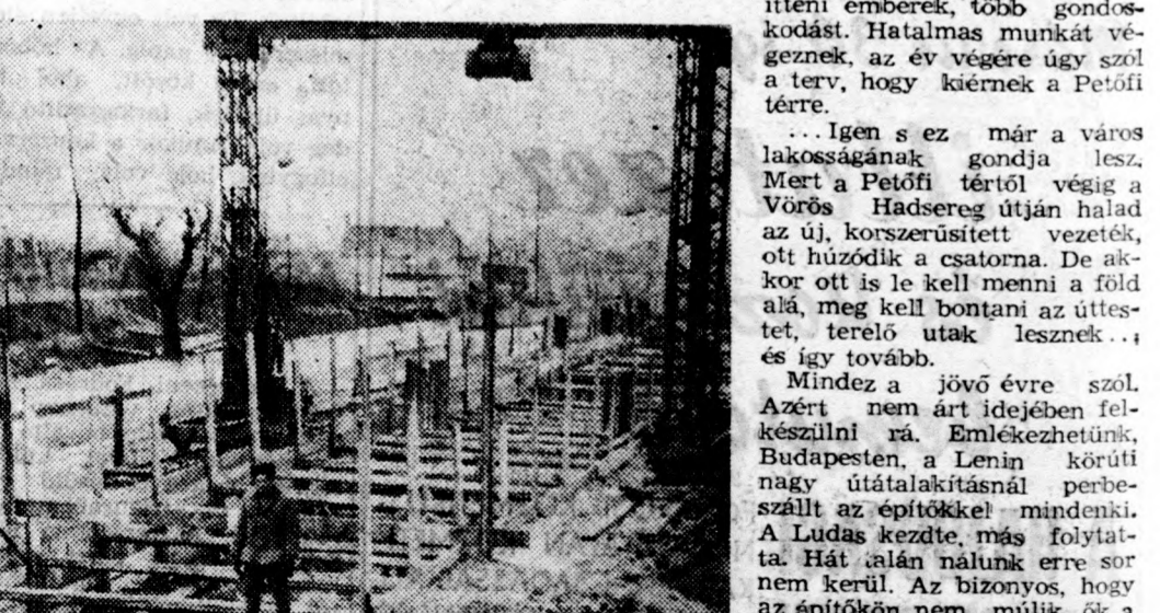
Ötven méter hosszúságban elkészült a korszerűsített hálózat első szakasza. Szerelik a kis darut, aztán gyérünk tovább. Irány a Petőfi tér!
