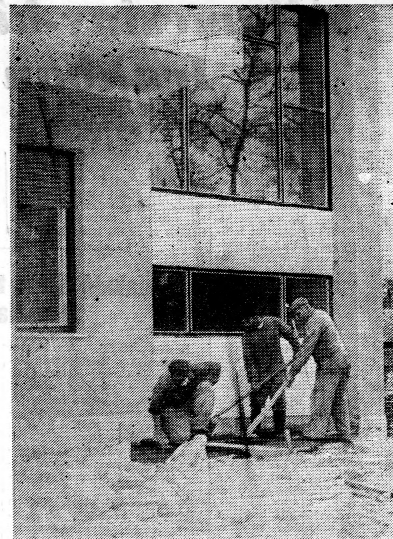
Befejező szakaszához érkezett Debrecenben a Nagyerdőn épülő vasútállomás. Képünkön Madar Mihály brigádja a járda betonozását végzi
