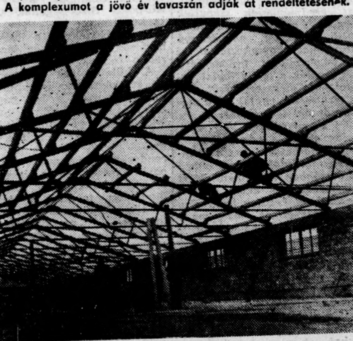
A földesi tojóház nevelőtelepének vasszerkezeti munkáin dolgoznak az építők
