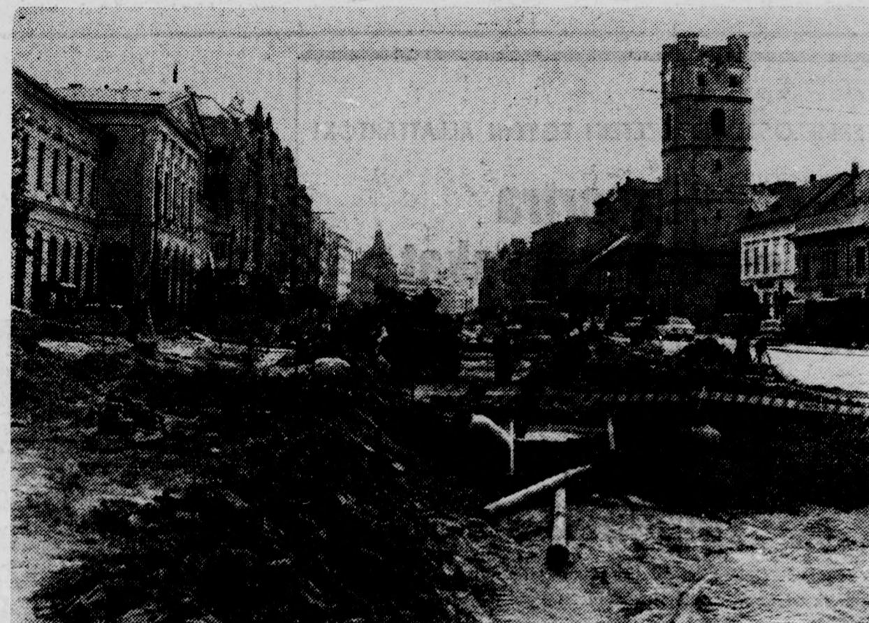
Az út- és villamosvasút-pálya építésének földmunkáit már a MÁV Igazgatóság épülete előtt végzik. Sok munkával jár az út alatt átvezető közmű-vezetékek lesüllyesztése
