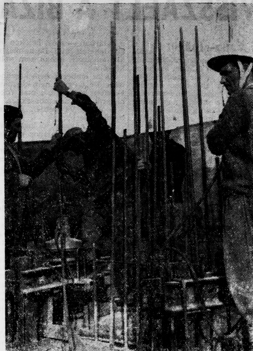
30 méter magasban, a csúszózsálya tetején. A képen látható berendezés emeli egyre magasabbra a zsálya, s a rajta dolgozó embereket
