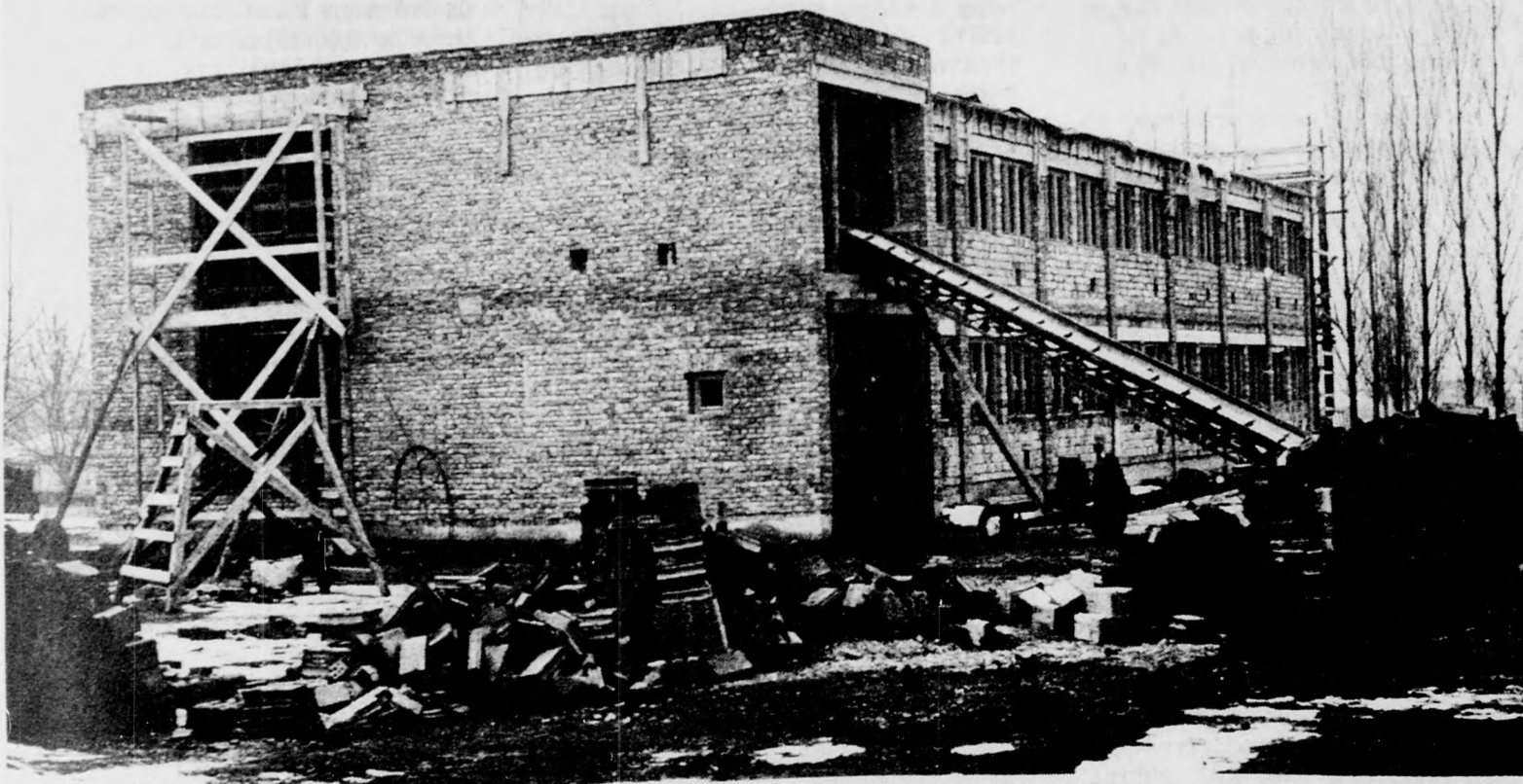
Ez évben az egész hajdúszoboszlói majort gázvezetékekkel szerelik fel. Gázzal működik majd az üzemi konyha, ezzel fűtik az étkezdét, a munkásszállást, a lakásokat, sőt a most ké- szülő egyemeletes irodaházat is. A tervek szerint májusra ez az épület is elkészül és akkor még nyugodtabb körülmények között folyhat a munka. Képzünk: a készülő új irodaház, a gazdaság középpontjában.
