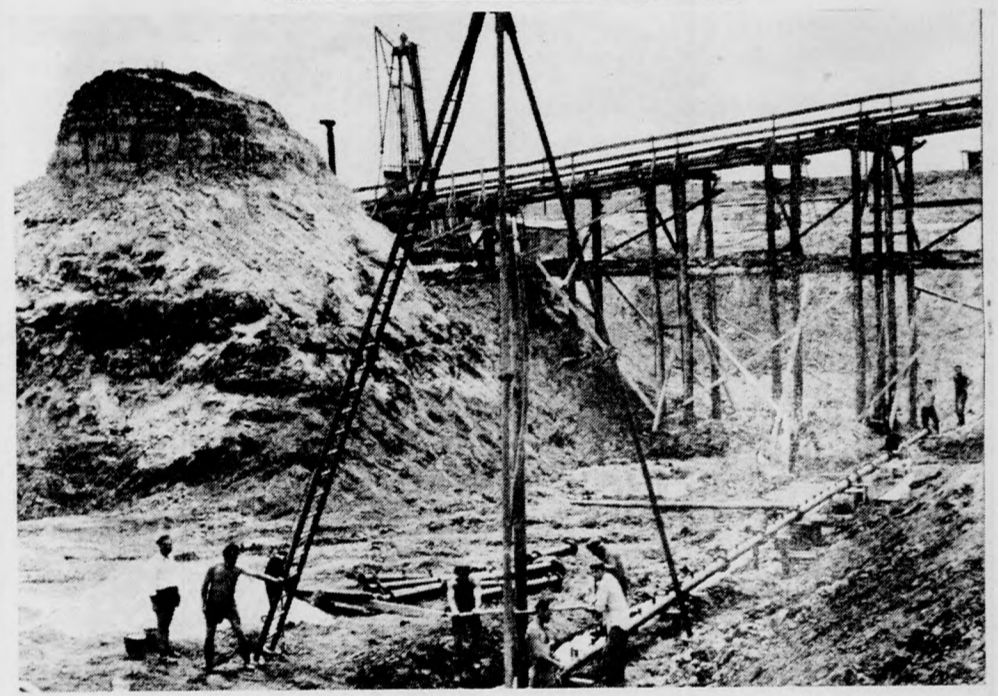
Kiskörénél, a II. Tiszai Víziépcső építésénél gyors ütemben halad a Tisza új medrének mélyítése. A több ezer négyzetméternyi területen már tíz méterre hagyták el az eredeti terepszintet. A földmunkák után előreláthatólag jövő tavasszal megkezdik a betonozást és a víziépcső műtárgyainak építését (MTI Fotó — Kácsor László felv.)
