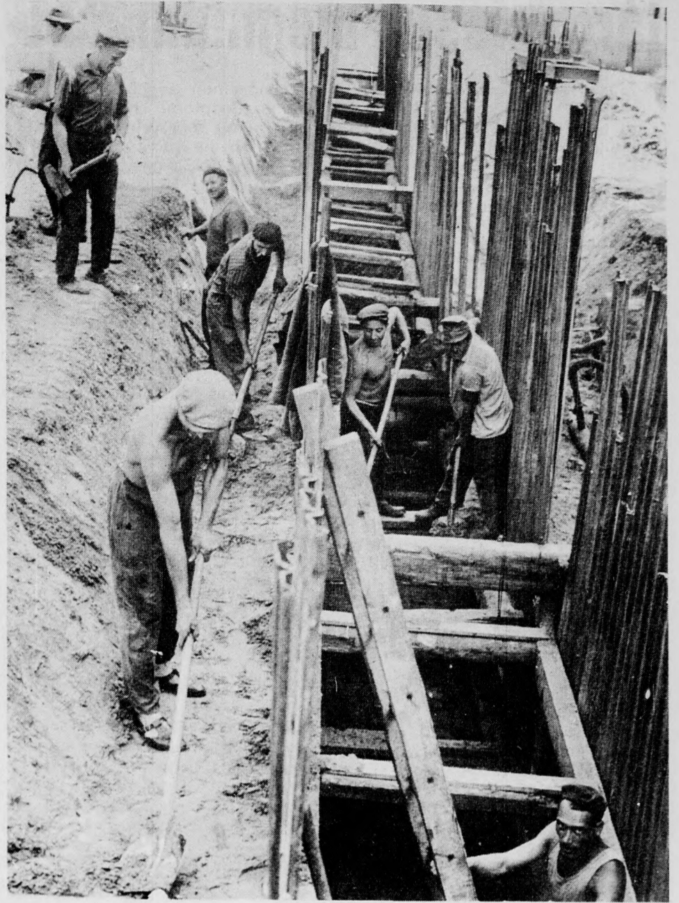
Megkezdődött Debrecenben a Munkácsy utcában a csatornaépítés. E munka fontos része a Dobozy lakótelep építése második ütemének. Ugyanis a Tanács utcától keletre — a régi temető helyén — a következő években több mint 1300 lakást építenek, s ezek közművesítésének alaphálózatát előre el kell készíteni. (Kalmár István felvétele)
