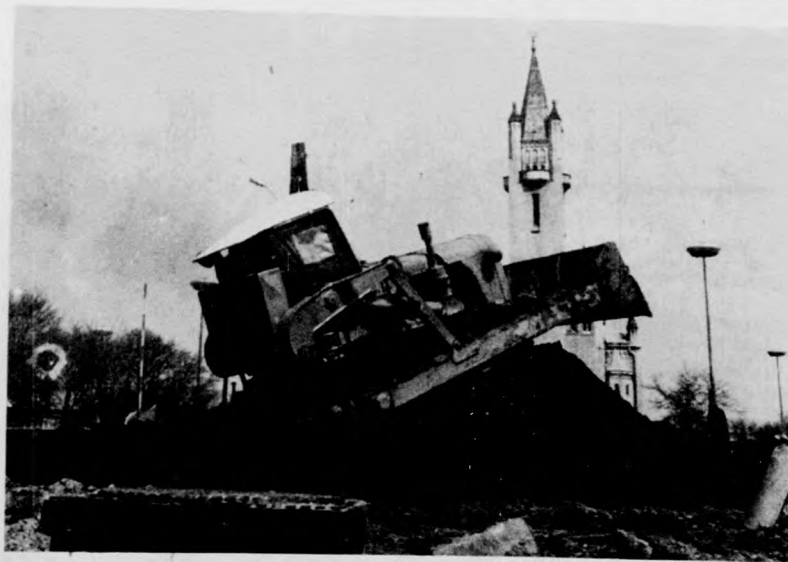
Lánctalpas talajgyalú egyengeti az új út alapjához a földet az Árpád térenél
