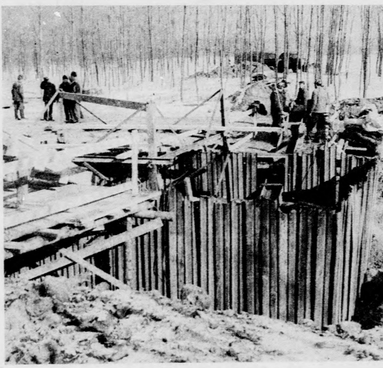
Elkészült az egyik oszlop alapja
