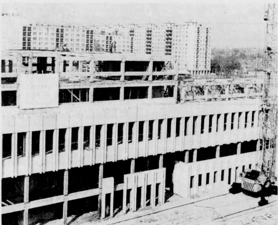
A Megyei Művelődési Központ épülő homlokzata a Déri Múzeum felől
