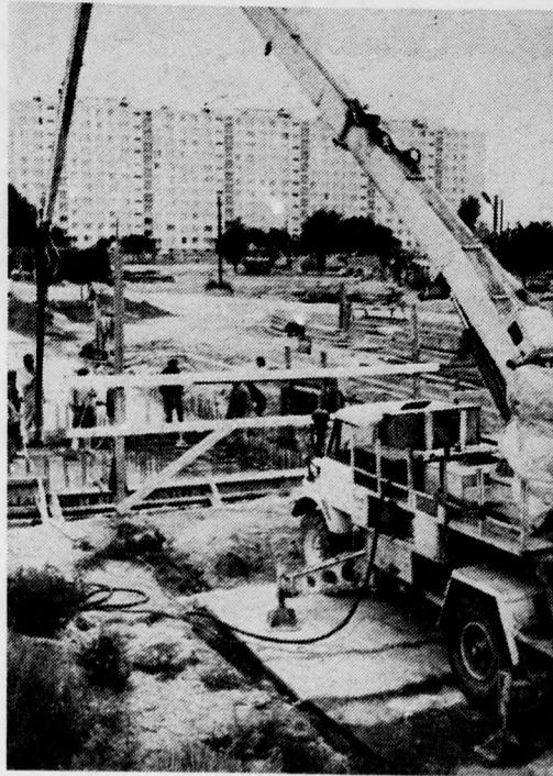
Munkában a betonozó brigád
