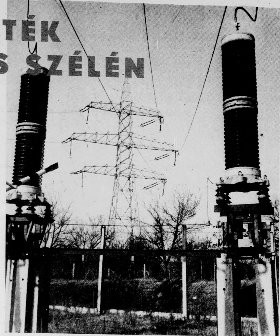
Ezen a 220 kilovoltos távvezetéken érkeznek a Hajdú-Bihar megyét el- látó villamos energia
