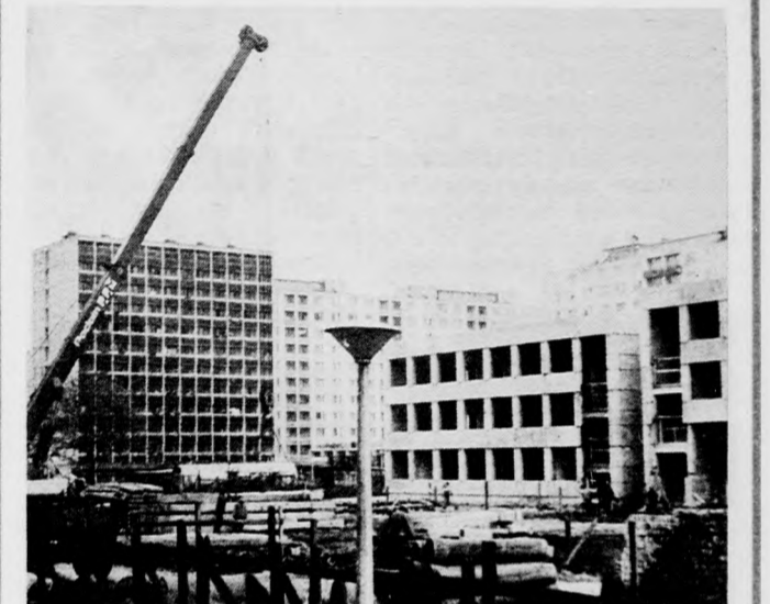
Megkezdődött a tornaterem építése
