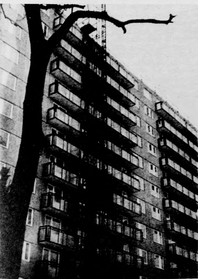
Az újonnan elkészült lakóház, ami négy éven át lesz a Kispesten dolgozó vidéki építők szállója
