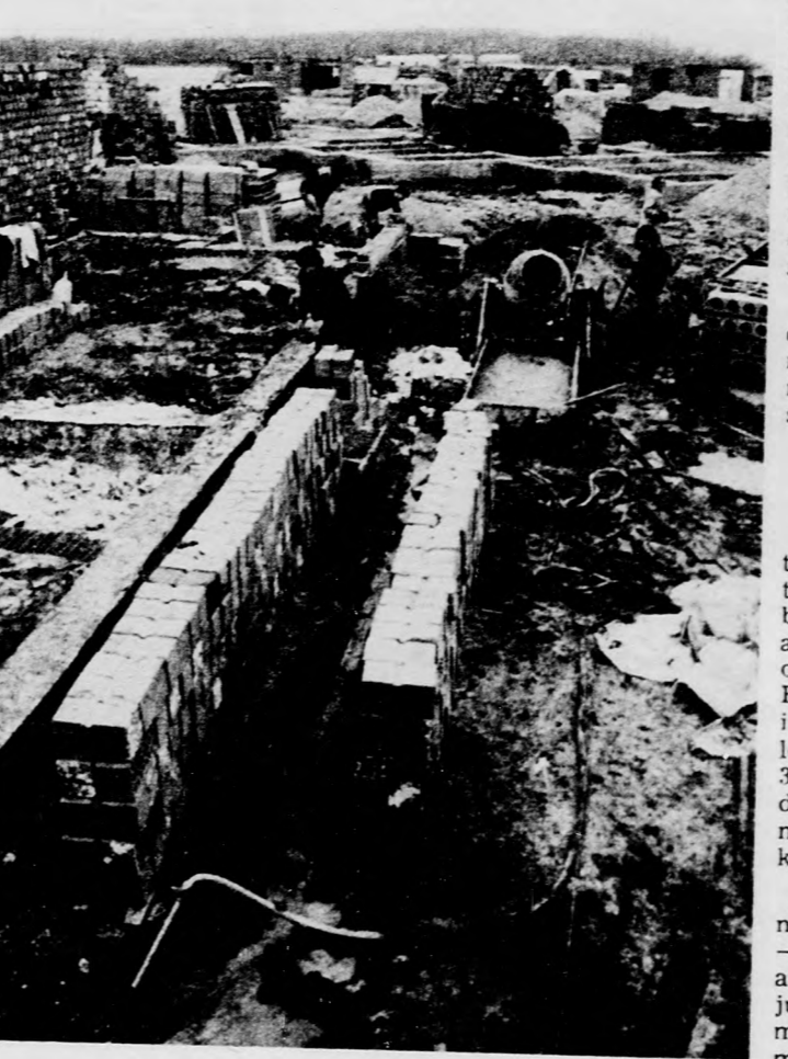
Építkezők a Bartók Béla úti, majdani lakótelepen (Fotó: Ikldy János)
