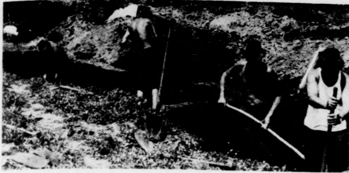
Rekkenő hőségben dolgoznak a kutatóárkokban a mun- kások. Mögöttük a kiemelkedő földhátan a lábasszín áll
