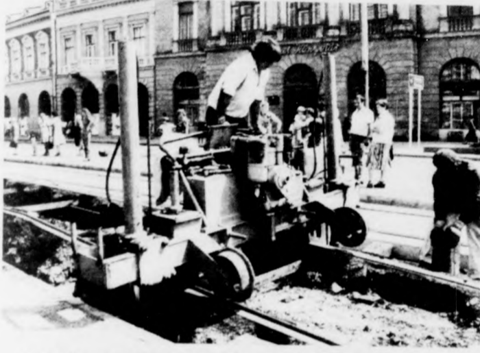
A Budapesti Közlekedési Vállalat speciális sínfelszaktító gépe segít a munkák gyors elvégzésében
