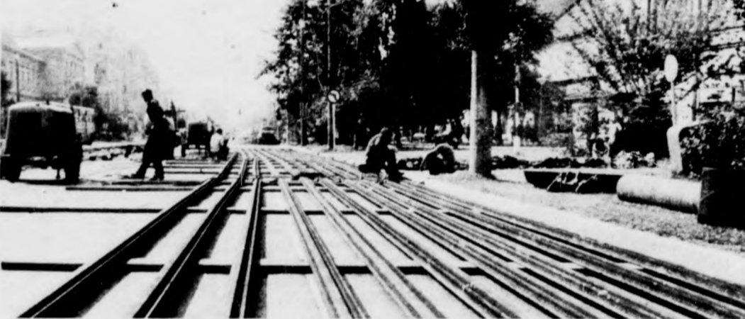
Előkészítve várnak az új sínek a behelyezésre
