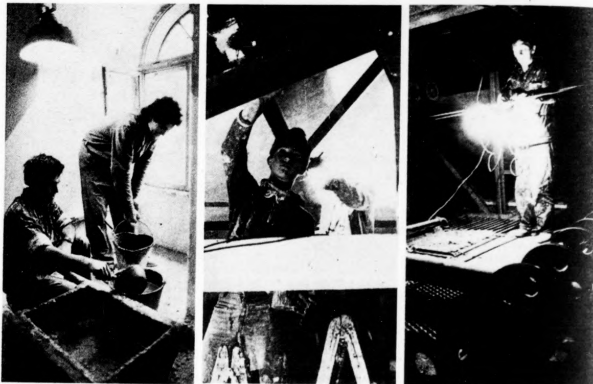
Az épület hátsó traktusában megkezdődött a belső vakolás ...
