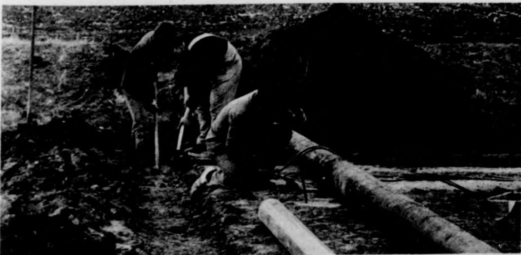
Csőfektetés a belvíz elvezetéséhez
