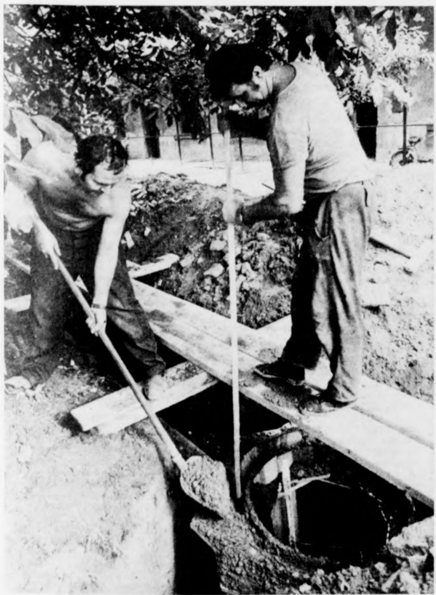
Szükségessé vált a víz- és szennyvízhálózat felújítása, jelenleg ezen dolgoznak a munkások
