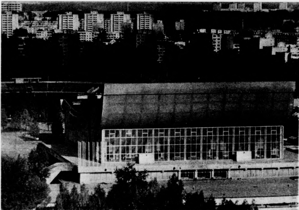
Az opera modern épülete
