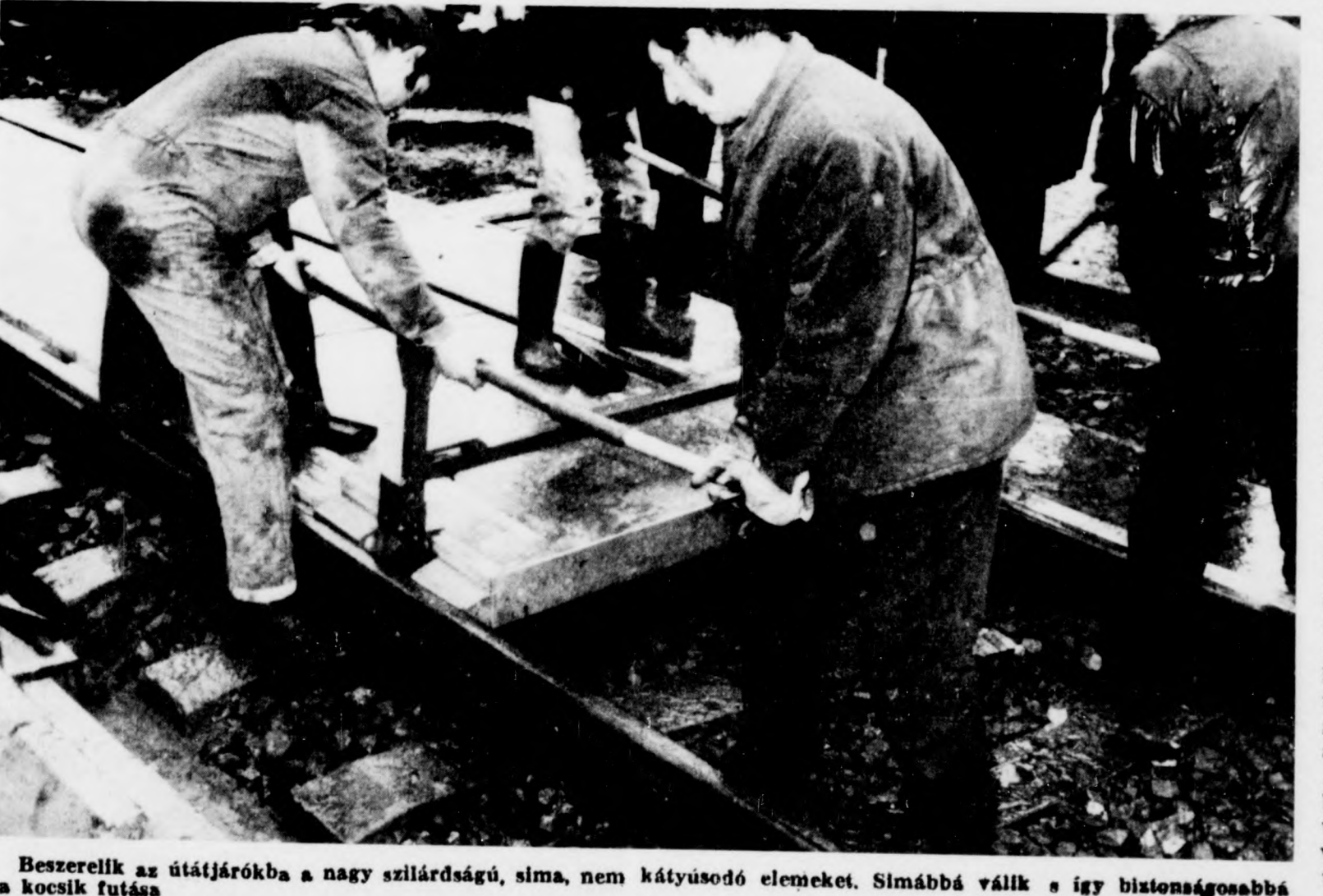
Beszereklék az utátjárókba a nagy szilárdságú, sima, nem kátyúsodó elemeket. Simábbá válik a így biztonságosabb a kocsik futása
