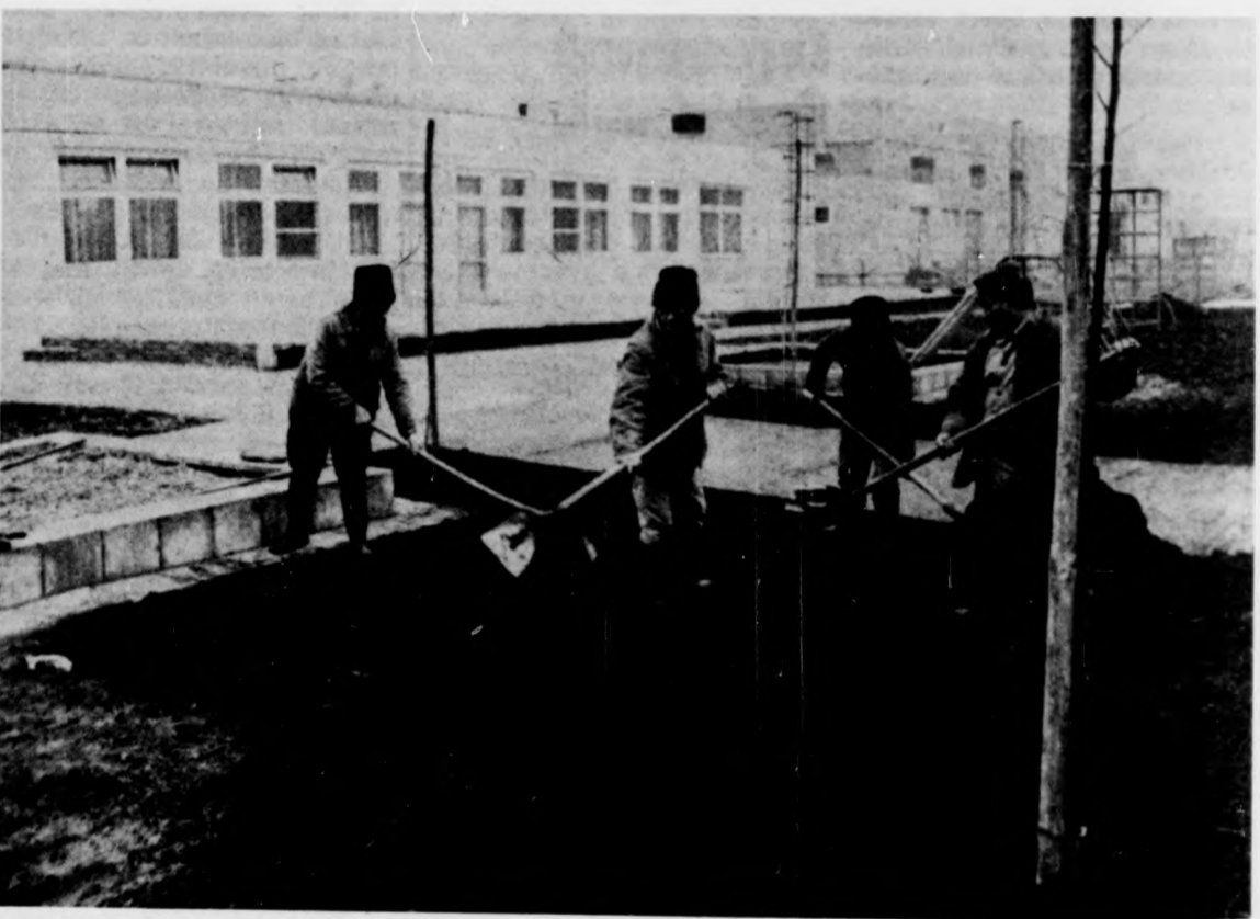
Épül a park
