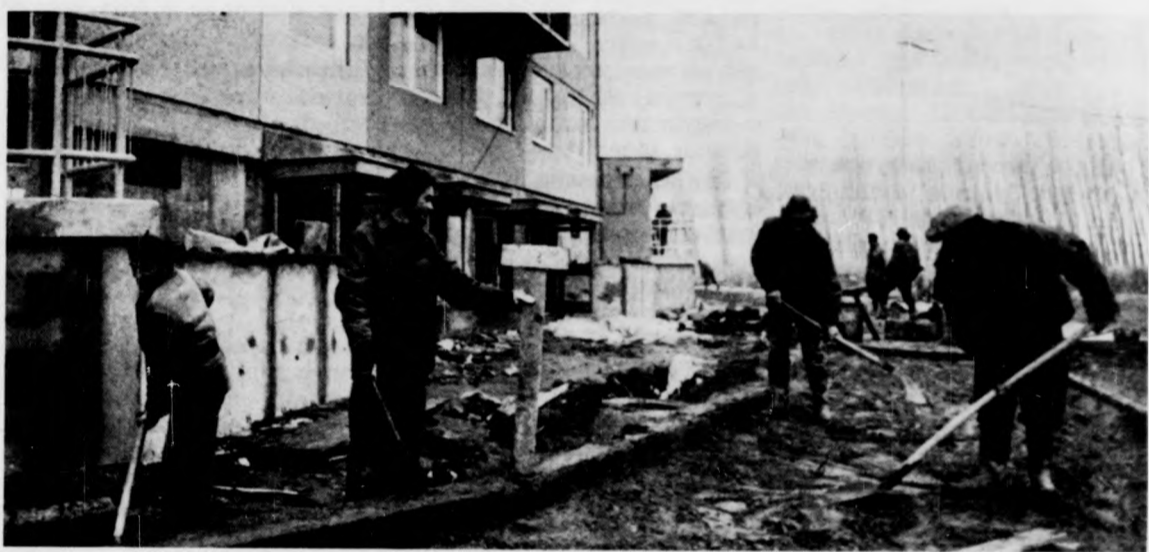
Épül a járda
