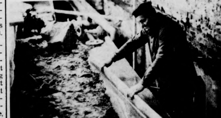
Betonozási munka az uszodában
