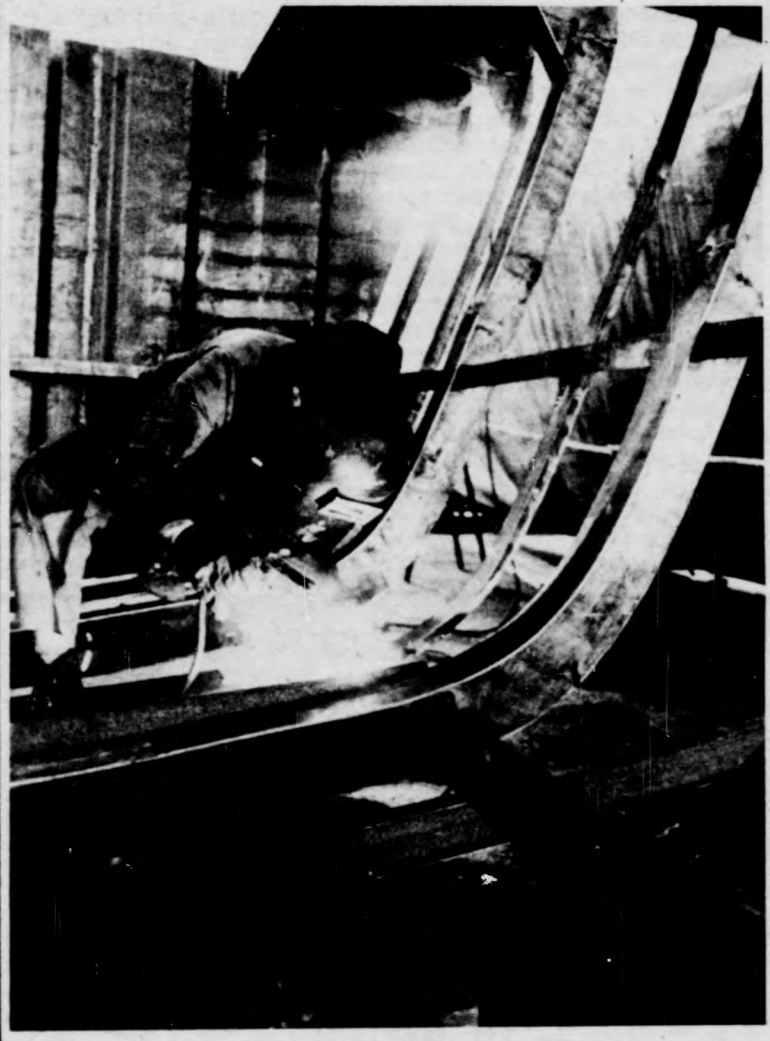
A Balaton laborhajónak még a vázát hegesztik
