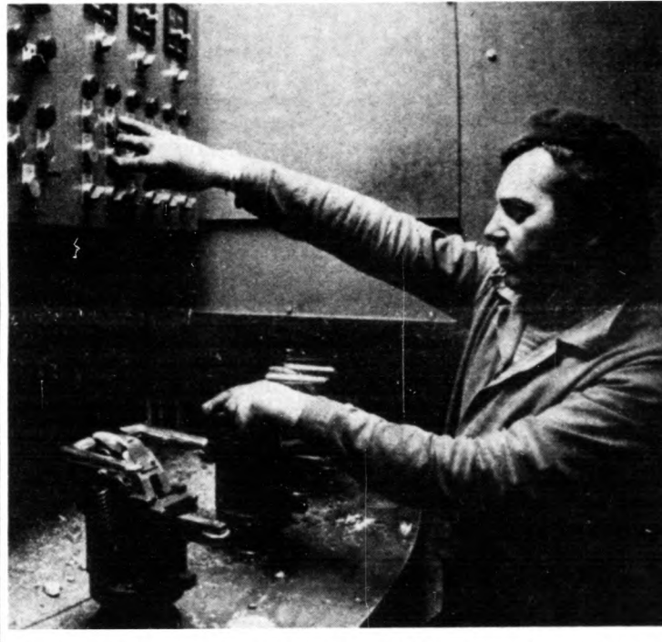
Ezt a Niederberger típusú fénysító berendezést Svájc-ból vásárolták
