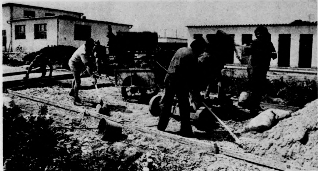
A bekötő út betonozása
