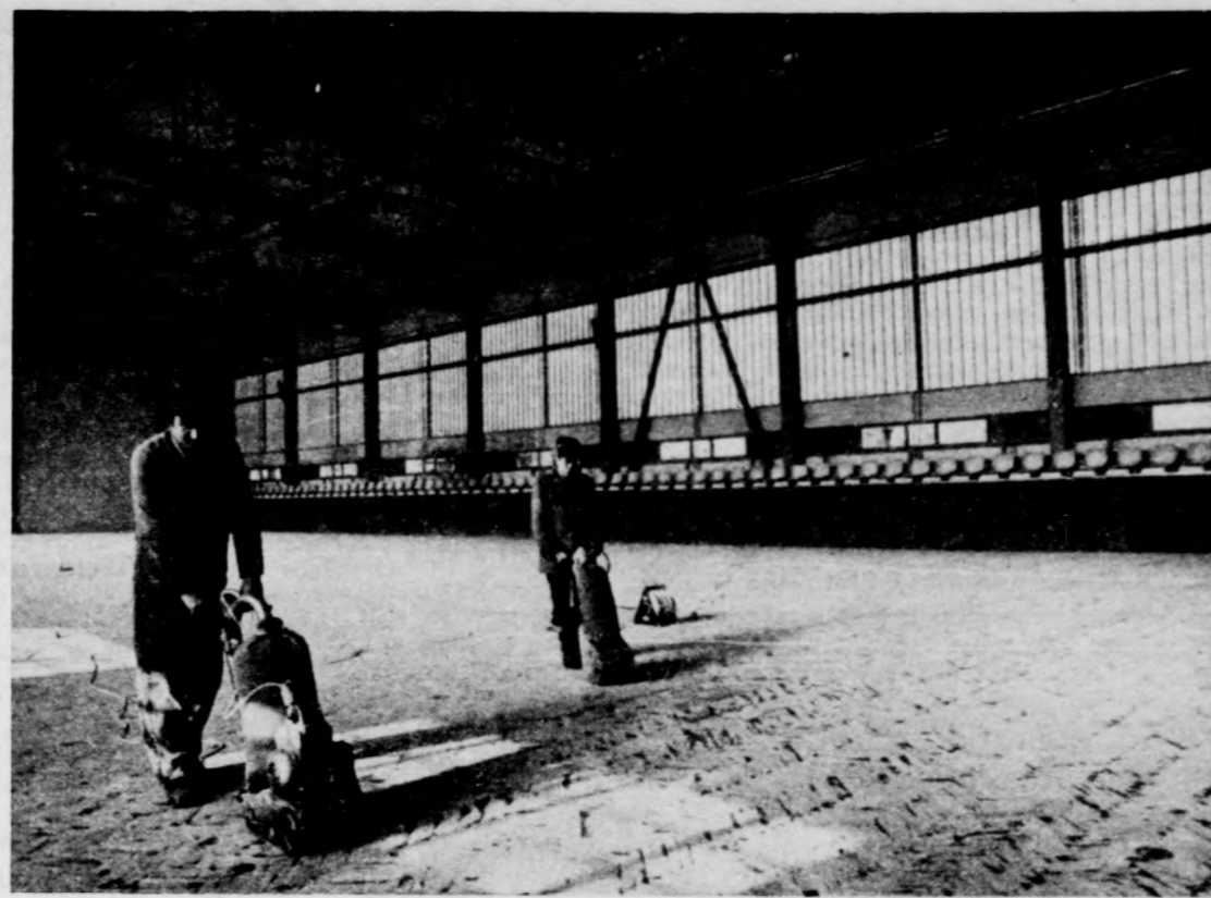
Sportcsarnok épül Hajdúböszörményben. Az épületben már a belső munkákat végzik
