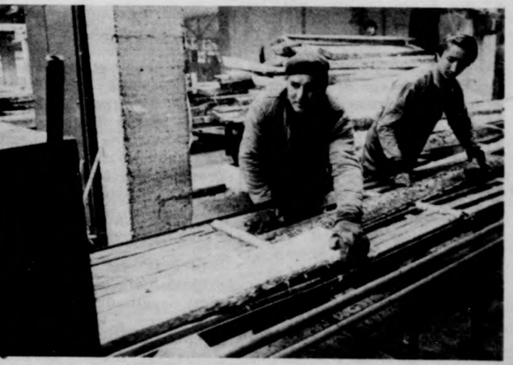
A sorozatvágó gép percnként 30 méter fa szelét vágja le (Fotók: Iklódy János)
