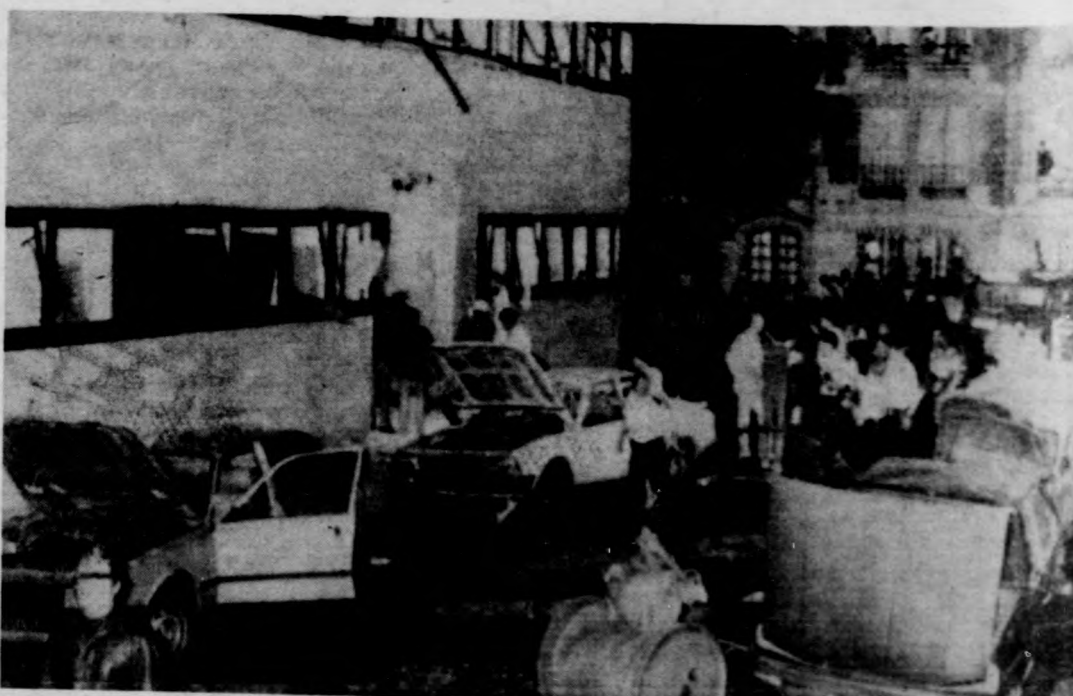
A „Közvetlen akció” nevű terrorcsoport vállalta magára a felelősséget azért a merényletért, amelyet pénteken virradó éjjel követtek el Párizsban. A képen: a, Európai Úrkutatási Ügynökség épülete, amelynek több emeletét teljesen romba döntötte a robbanás (Telefóto: AP — MTT — KS)
