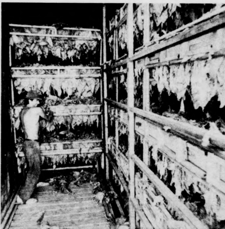
A pajtában 6-7 napig szárítják meleg levegő befúvásával a dohányt
