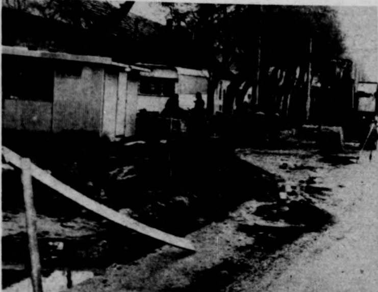
Új közlekedési sávot építenek a Hatvan utca és a Segner tér torkolatában
