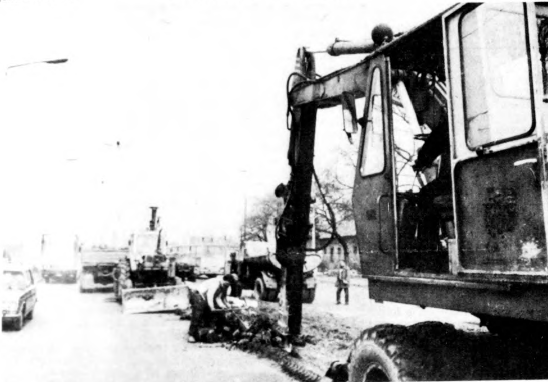
A trolivonal uttest-korszerűsítése az Erzsébet utca és a Segner tér között
