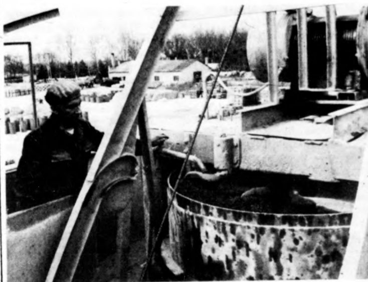
Betont kevernek a blokkgyártó gépsorhoz
