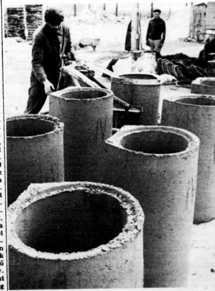
A csőgyártóból frissen kikerült beton átereszek (Fotó: Nagy Gábor)
