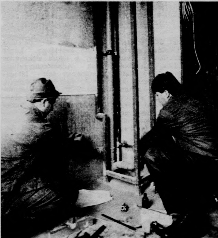
Munka közben a győztes szerelőpár: Vatter István és Dobszai János, a Hajdú megyei Állami Építőipari Vállalat dolgozó
