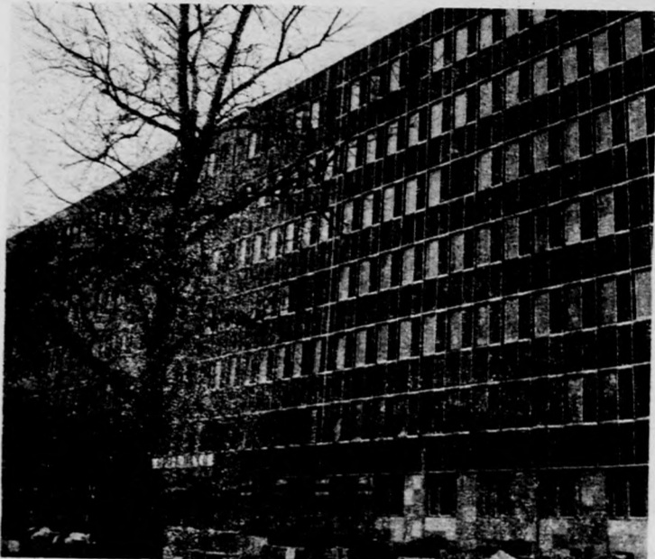
A Hajdú Megyei Állami Építőipari Vállalat egyik legnagyobb munkája a debreceni, Bartók Béla úti kórházbővítés
