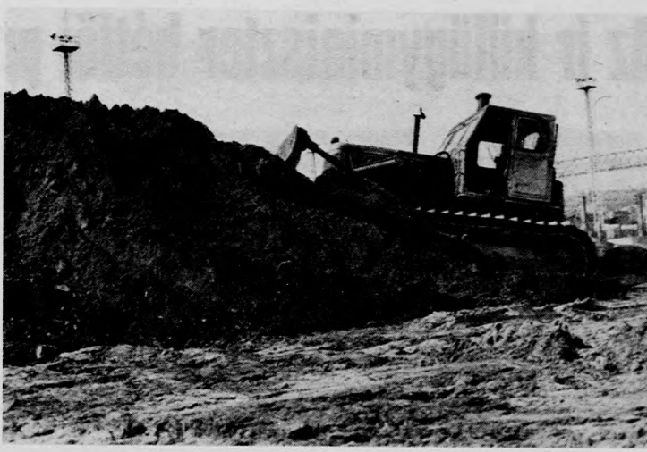
Több ezer köbméter földet kellett megmozgatni az új benzinkút építéskor
