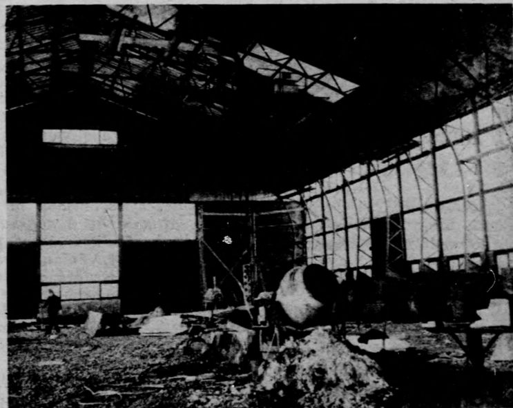
A leendő hulladékfeldolgozó új csarnoképületéhez tavaly augusztusban fogtak hozzá
