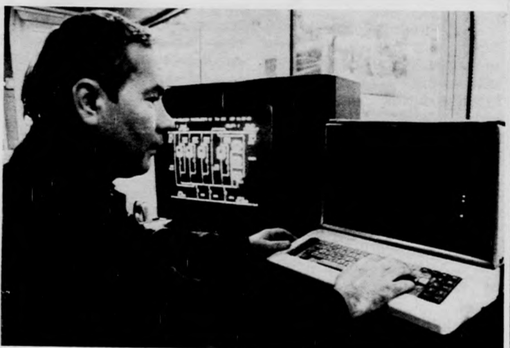
A forróvíz-rendszer központi irányítása a KA 6 alközpontban történik
