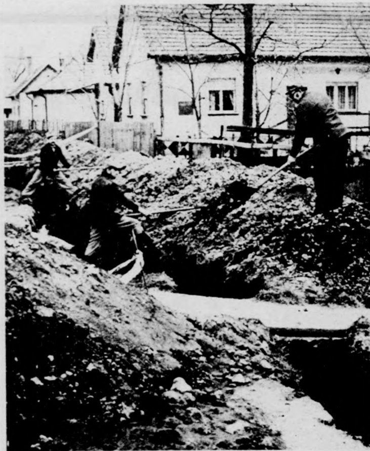
Épül a gázvezeték
