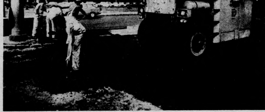
Aszfalttömörítés úthengerrel (Iklódy János felvételei)
