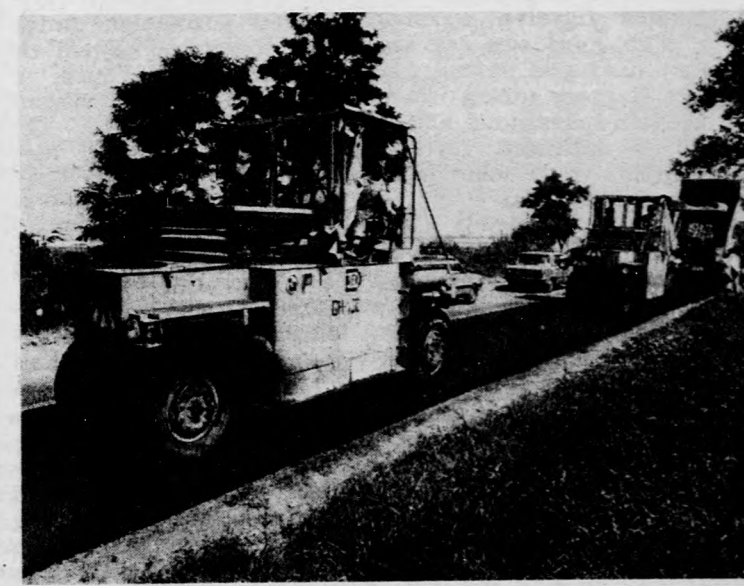
Üthengerekkel tömörítik a frissen terített aszfaltot (Fotók: Iklódy János)
