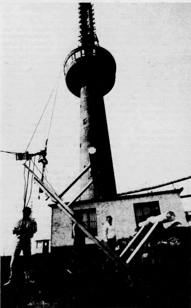
A Ganz-Epszer dolgozói felhúzzák a toronyba az antennapanelokat (Fotó: Balogh Imre)
