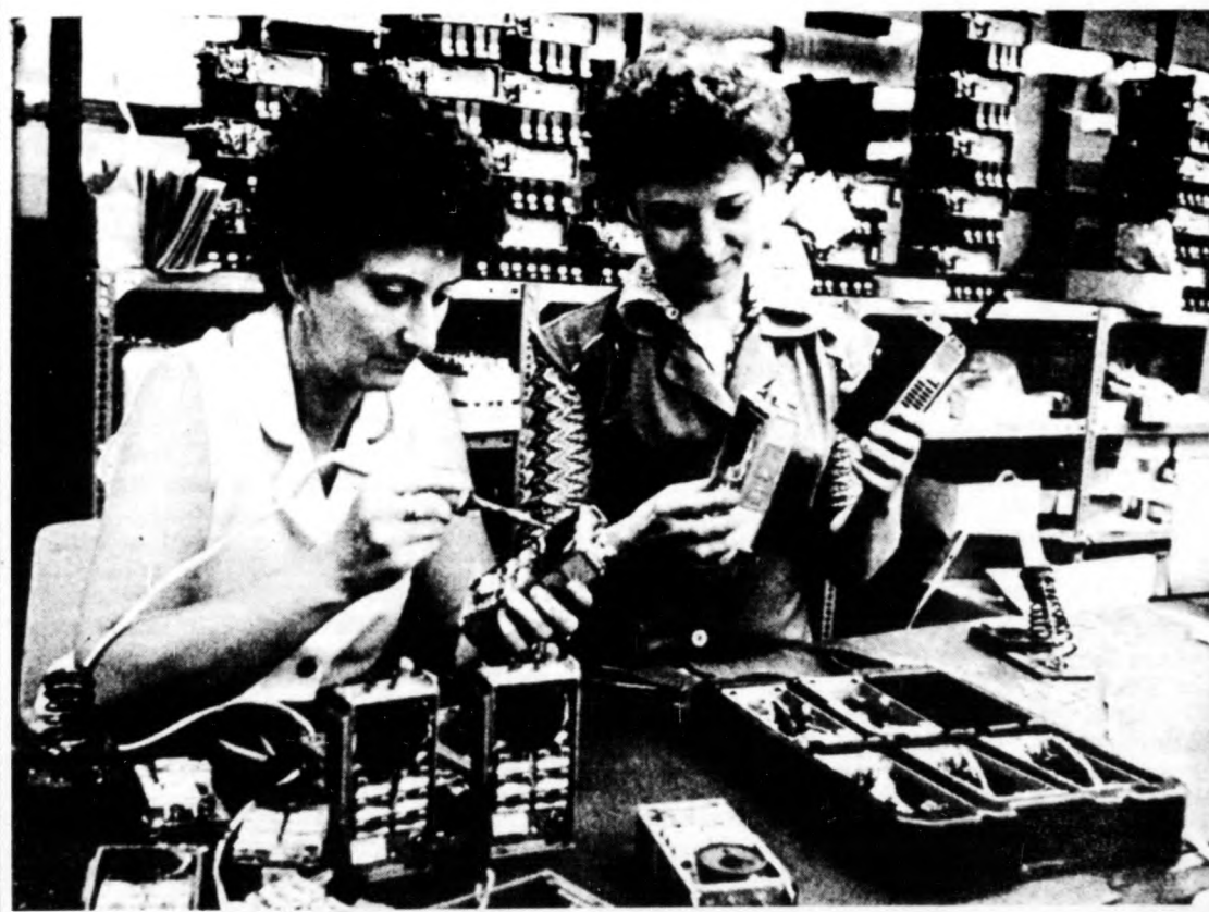
A BRG Mechatronikai Vállalat Salgótarjáni Rádiótechnikai Gyárában az idén kezdtek el az FM 503-as típusú adó-vevő próbagyártását. Ebben az évben ezerháromszáz darabot szereznek össze a kétvatos, hatfrekvenciás korszerű berendezésből. Ezeket a szovjet és a hazai piacon értékesítik. Képvonlat: a nullszéria összeszerelése látható (Fotó: Rigó Tibor — KS)
