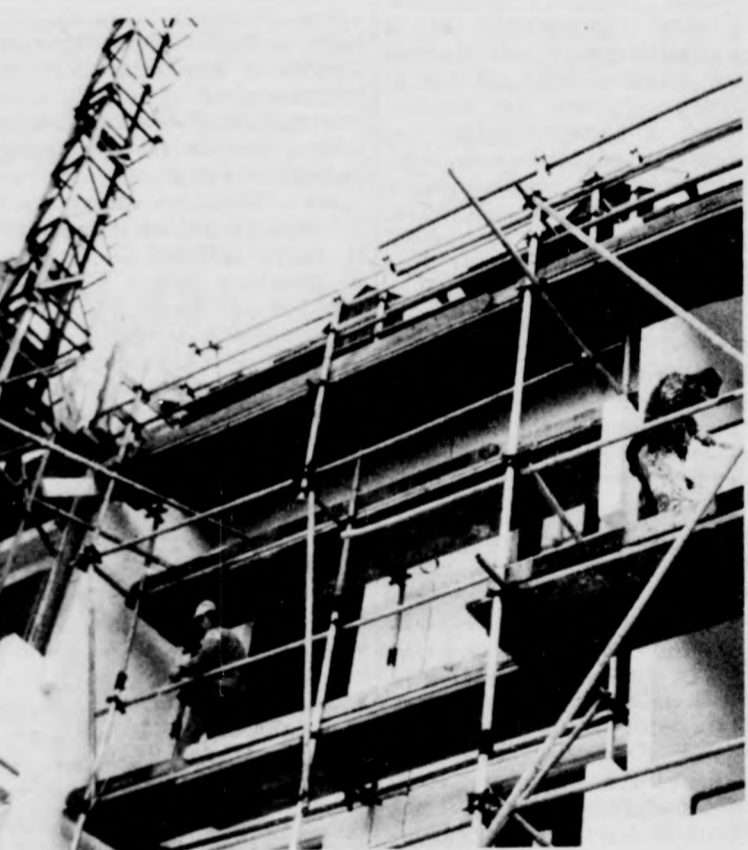
Munkában az ácsok a Tócs-völgyi építkezésen
