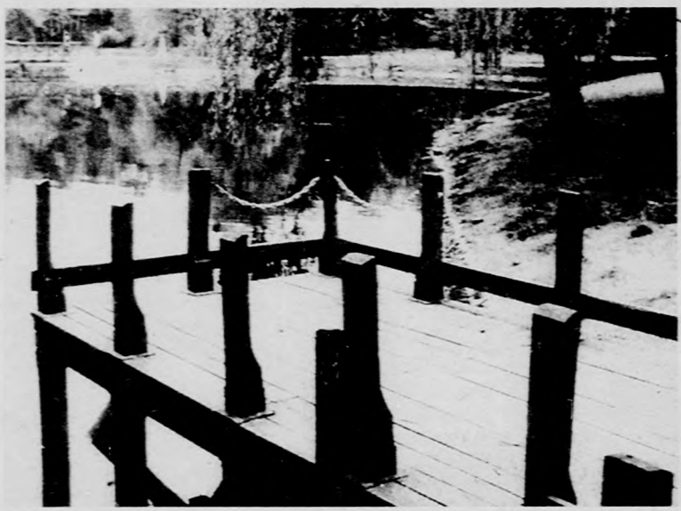
A Nagyerdel-tó partján álló kis móló korlátjai hiányosak, a láncot több helyen leszaggatták a faoszlopokról, a móló így balesetveszélyes. (Könyves Tóth István felvétele)
