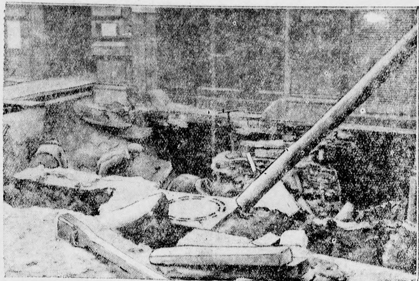
Egy berlini bérház, amely előtt eltört a vízvezetéki cső és besüppedt a föld. Ez összeomlással fenyegeti a bérházat.
